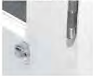
Instalación dentro de vano
