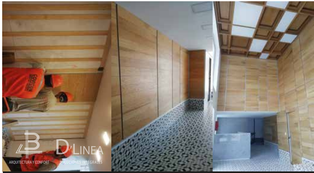
REVESTIMIENTO Y ESTRUCTURA DE MADERA
