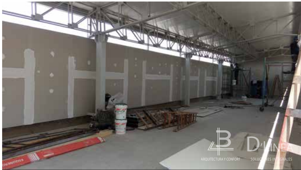
ESTRUCTURA DE DRYWALL
