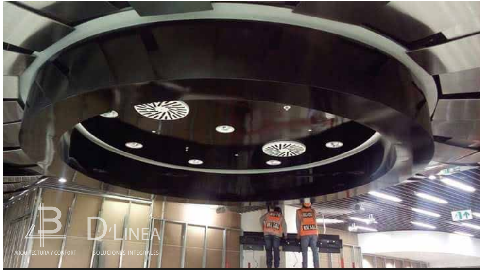
ZONA DE PASILLO - ESTRUCTURA DE MADERA
