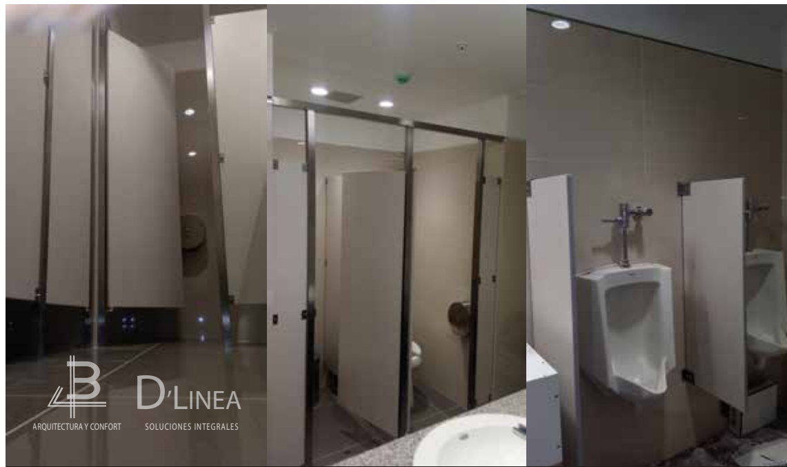
ESTRUCTURA DE ACERO INOX Y MELAMINE
