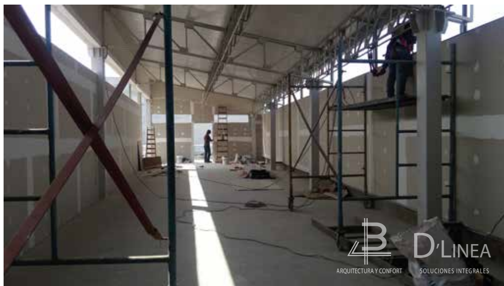
ESTRUCTURA DE DRYWALL
