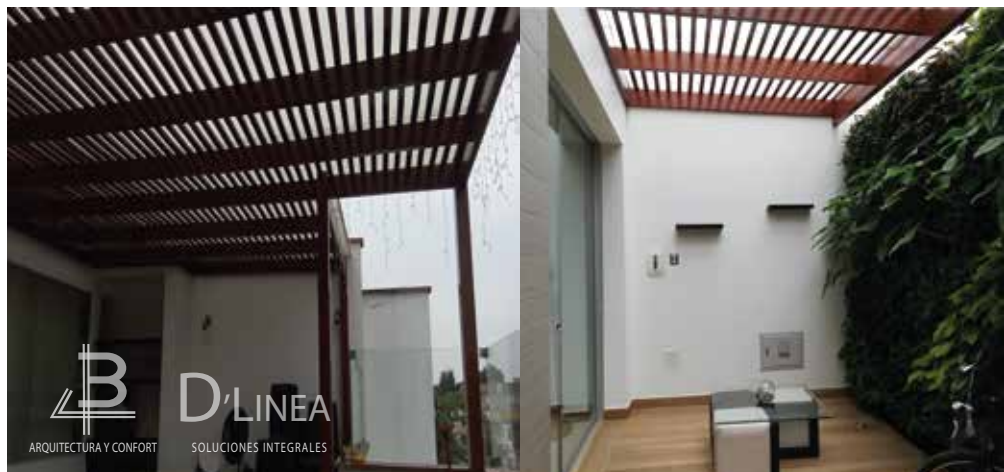
ESTRUCTURA TECHO SOL Y SOMBRA DE MADERA
