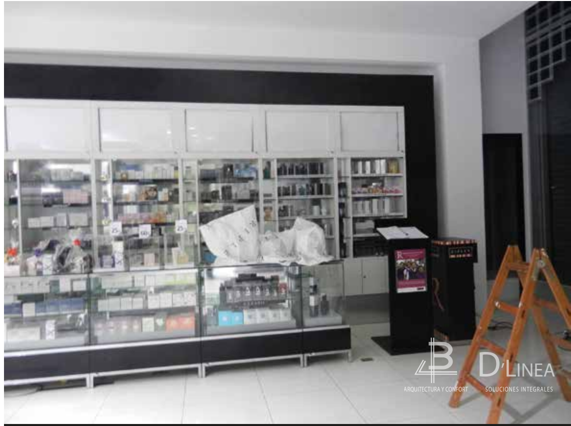
ZONA DE EXHIBICIÓN- ESTRUCTURA Y DECORATIVO DE MADERA
