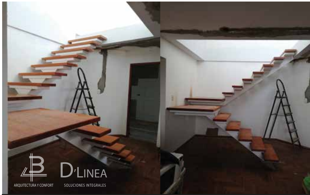
REVESTIMIENTO DE ESCALERA EN MADERA
