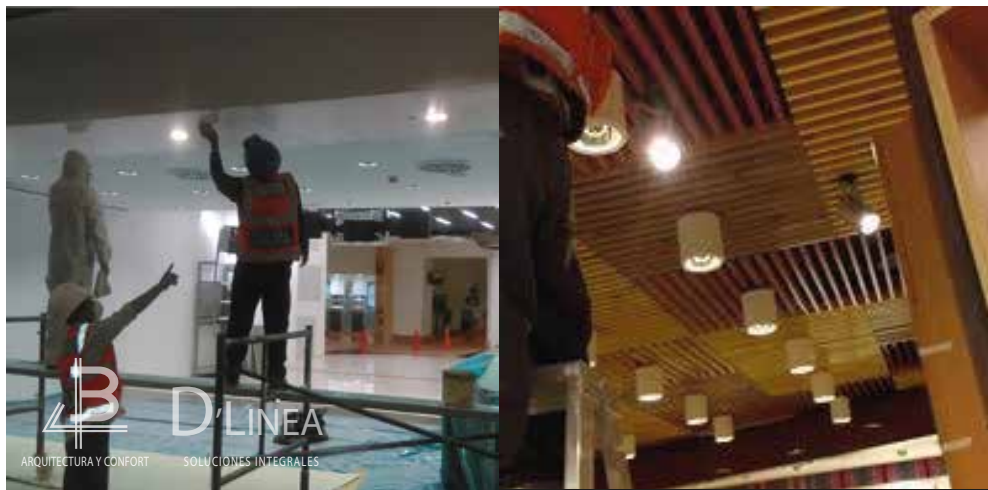
ESTRUCTURA DE MADERA
