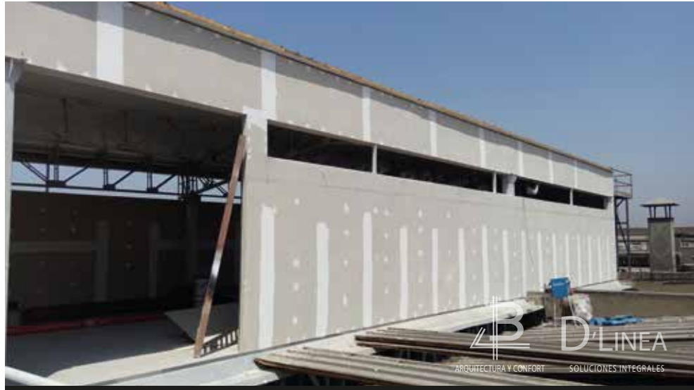
ESTRUCTURA DE DRYWALL
