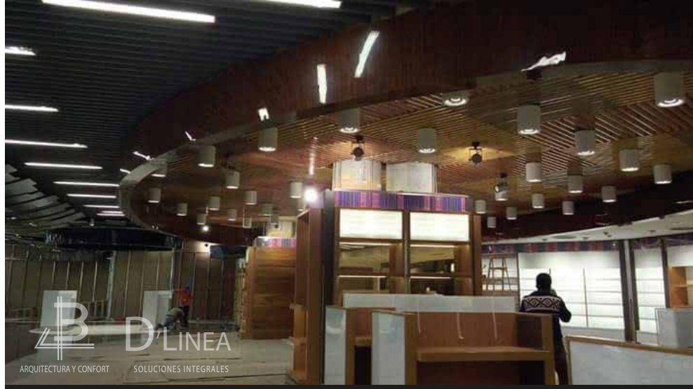
ZONA DE EXHIBICIÓN - ESTRUCTURA DE MADERA
