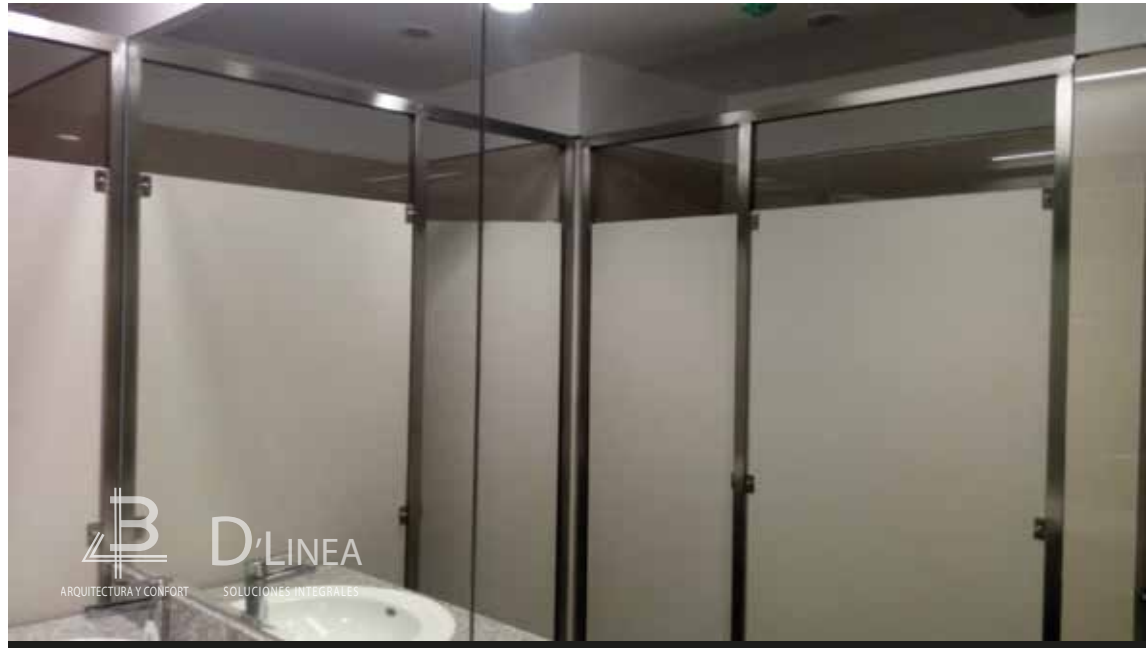
ESTRUCTURA DE ACERO INOX Y MELAMINE
